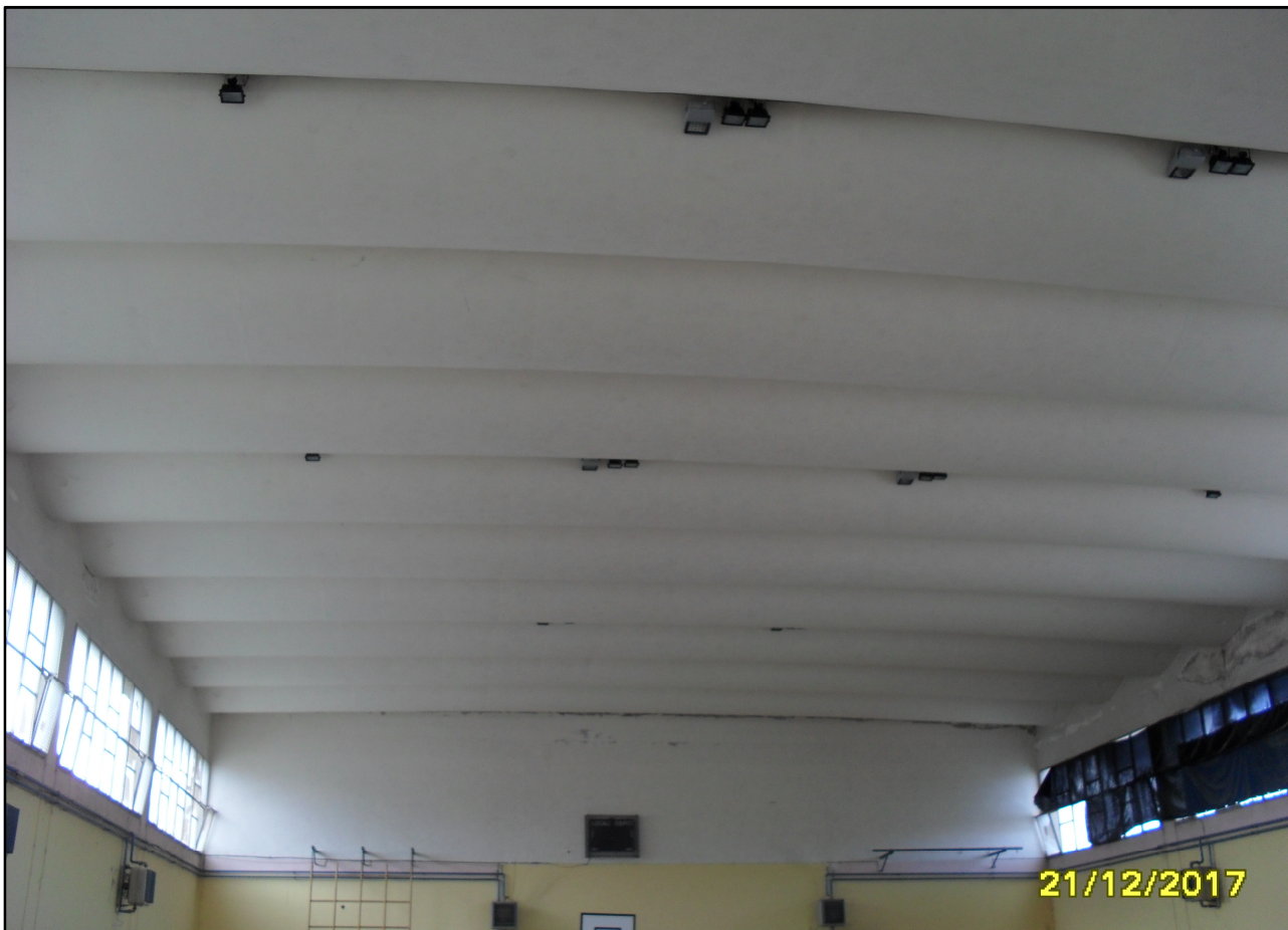
Foto n. 3: vista interna della copertura della palestra realizzata con tegoli in c.a.p.
