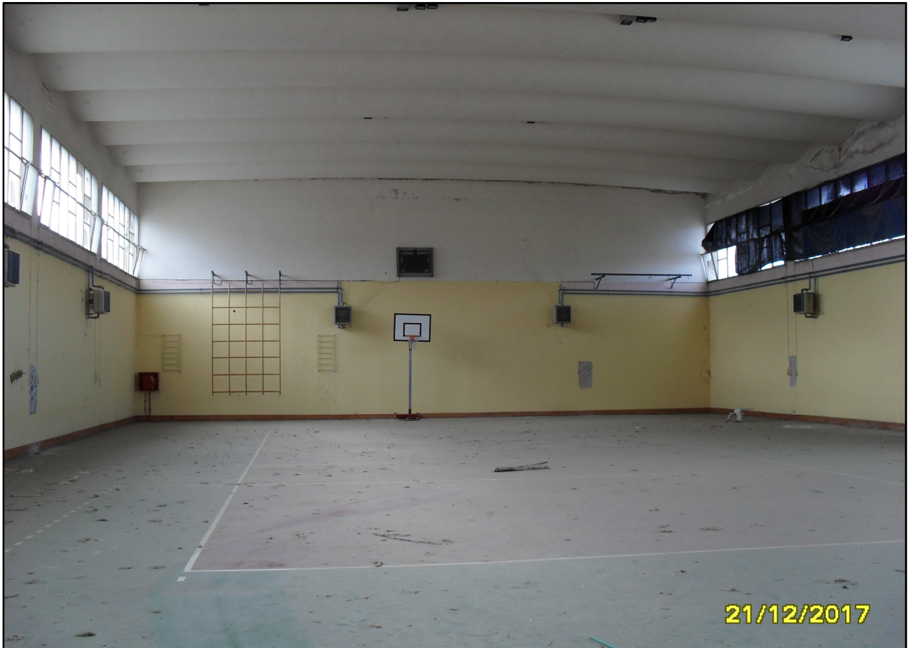
Foto n. 1: vista interna della palestra verso il lato sud-ovest.
